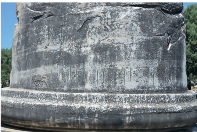
Abb. 69: Vorritzungen zur Herstellung von Kanneluren an einer Peristasis-Säule des Tempels von Didyma auf dem Territorium von Milet, Foto: Ch. Berns.
