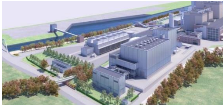
GuD Herne: Hocheffizientes Gas- und Dampfturbinenkraftwerk (KWK)
