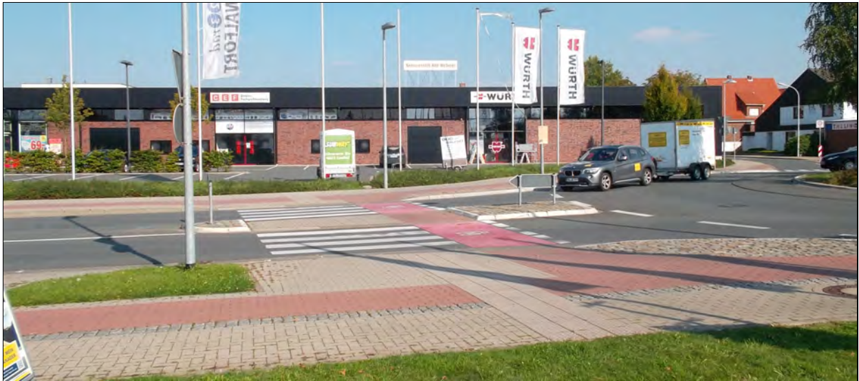
Abbildung 71: Kreisverkehr Coesfeld, Dülmener Straße – Einfärbung der Radfahrerfurten
