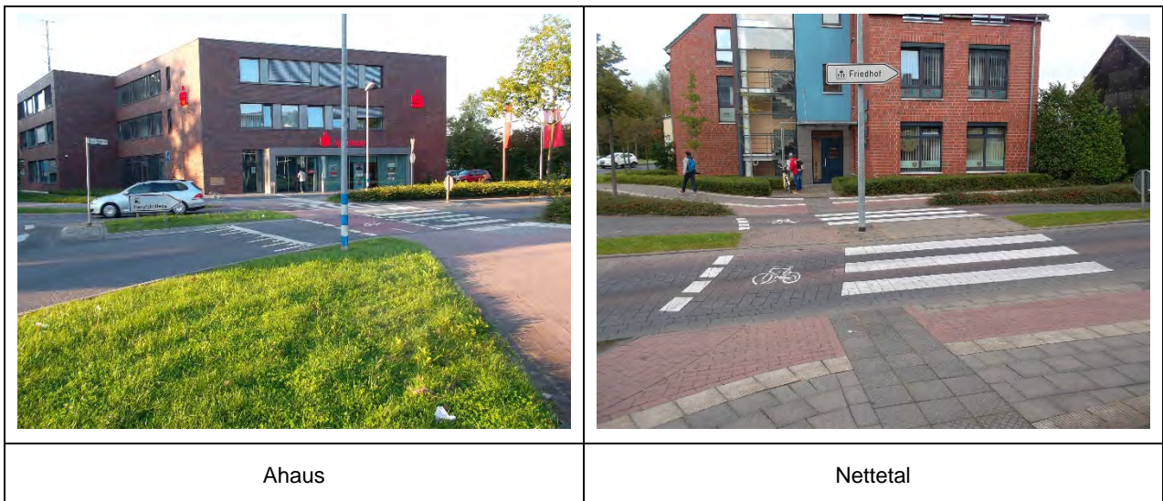
Abbildung 50: Aufpflasterung der Querungsstellen
